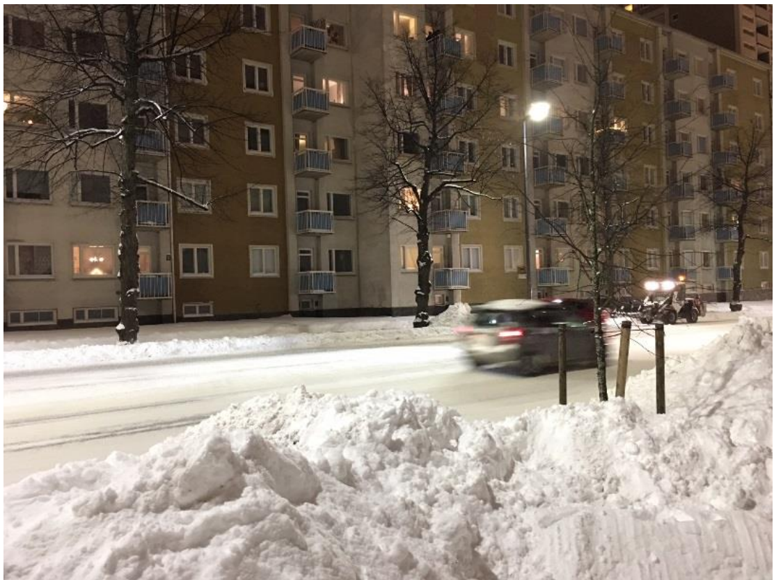
Kuva 16. Satakunnankatu 34-32 julkisivu parvekkeineen.
